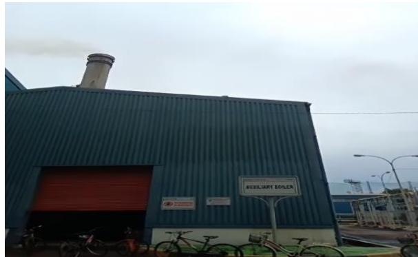
Gambar 1. Auxiliary Boiler (Sumber: Dokumentasi Pribadi)
