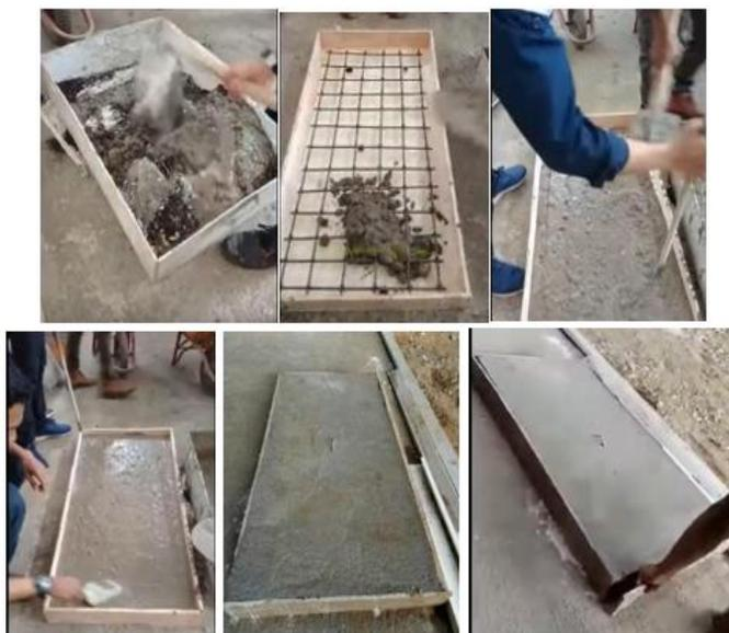
**Gambar 3.** Proses Pembuatan Plat Beton Knockdown
