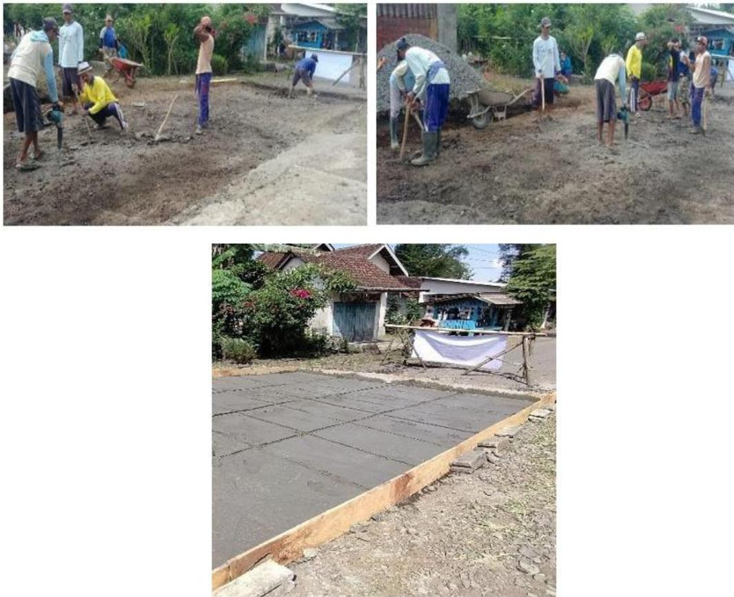
**Gambar 4.** Proses Pengelupasan sisa-sisa aspal dan material subbase serta pengaplikasian panel-panel beton
