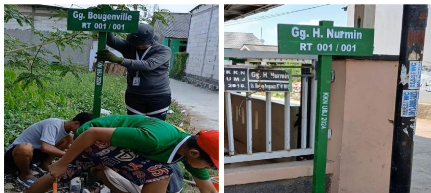
Gambar 4 Kegiatan pembuatan dan pemasangan plang jalan
