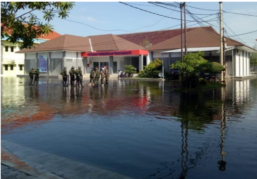
Gambar 9. Genangan Air Hujan di depan Gedung YPP Universitas Pancasakti Tegal tanggal 28 Pebruari 2020
