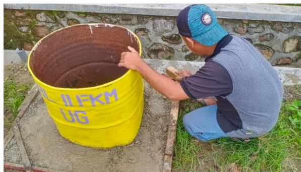
Gambar 2. Tempat Sampah Ditanam Menggunakan Semen
